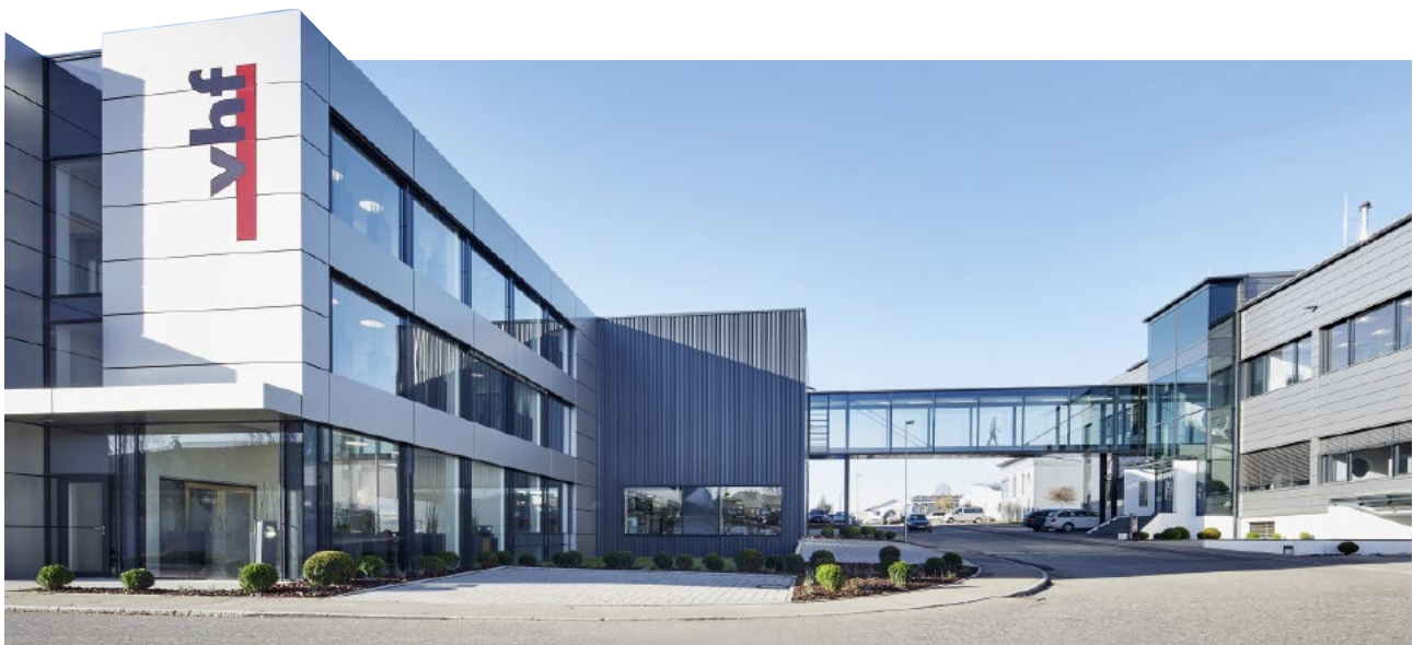
► Am Stammsitz Ammerbuch befinden sich Administration, Entwicklung und Fertigung unter einem Dach.
